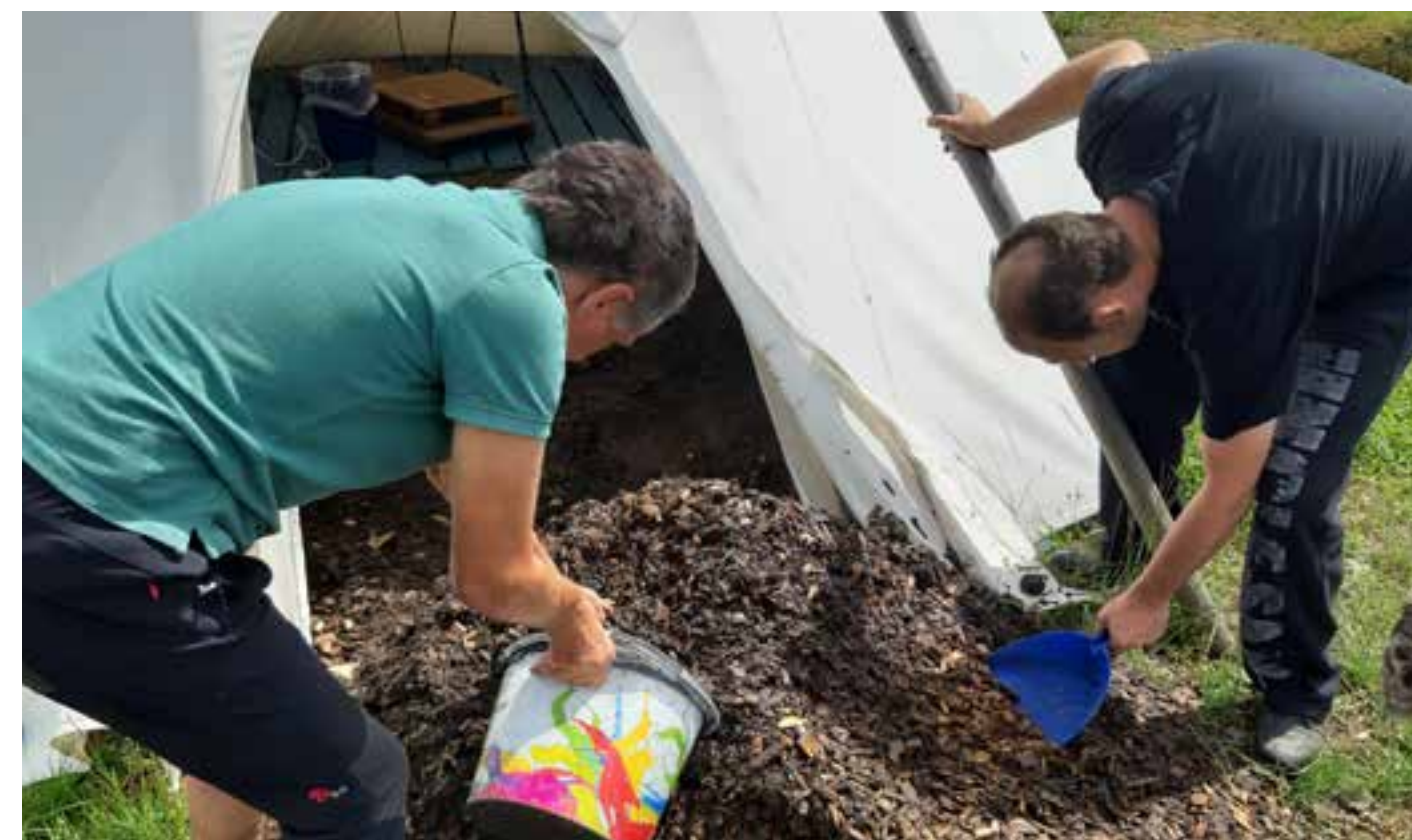
Zeltreinigung nach dem Hochwasser
