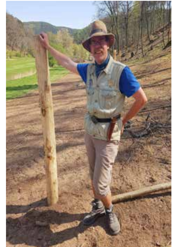
Michael Runkel beim Zaunbau
