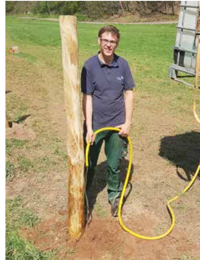
Jeder einzelne Pfehl musste eingewässert werden, Philipp ist da Spezialist
