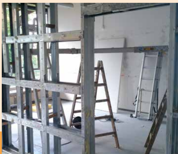
Die neue Klasse - im Bau
