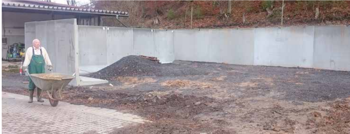
Neue Dunglege, die Bodenplatte muss noch betoniert werden
