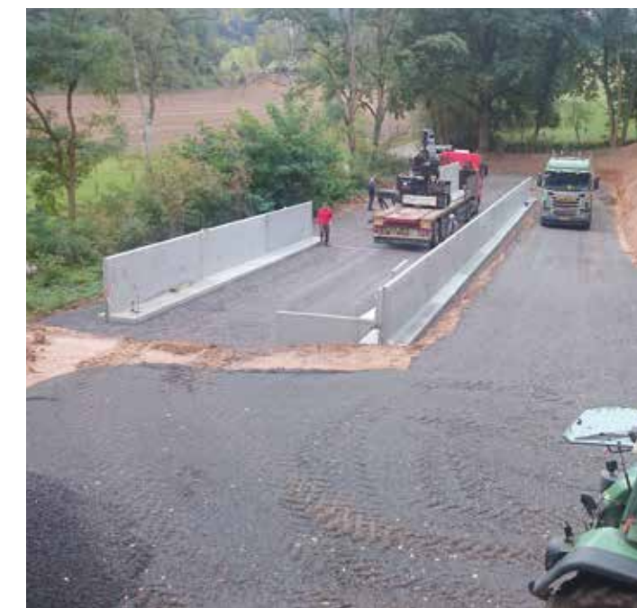
Im Bau befindliches Fahrsilo mit einem Fassungsvermögen von 500 m 3
