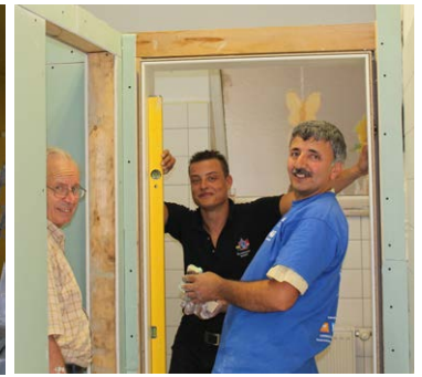
Die neuen Trennwände
